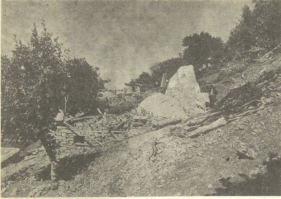
Sekil 11: Yamaçlı'da depremde yandaki yamaçtan koparak yuvarlanmış ve bir evin 2 odasını kaplamış kayalar.
